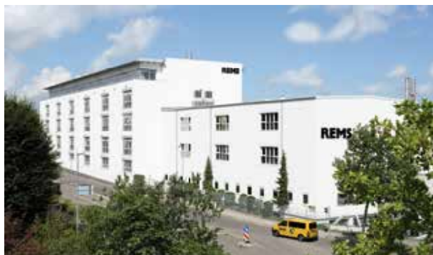
Обучающий центр REMS в г. Вайблинген под Штутгартом.
